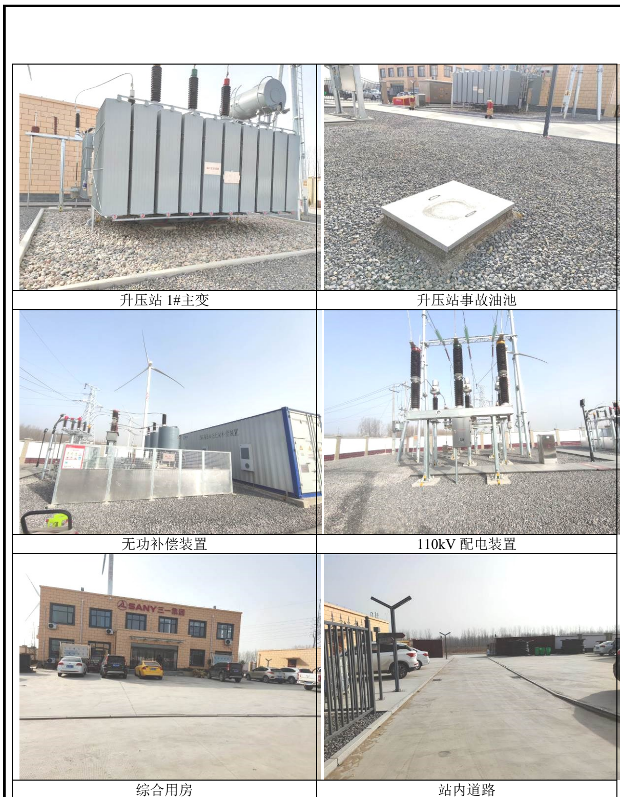
图 4-3 风电场升压站站设施情况
