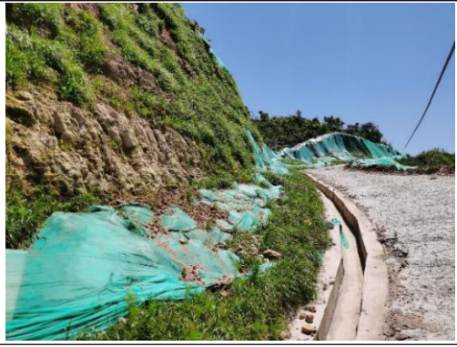
16#风机往升压站道路排水沟
