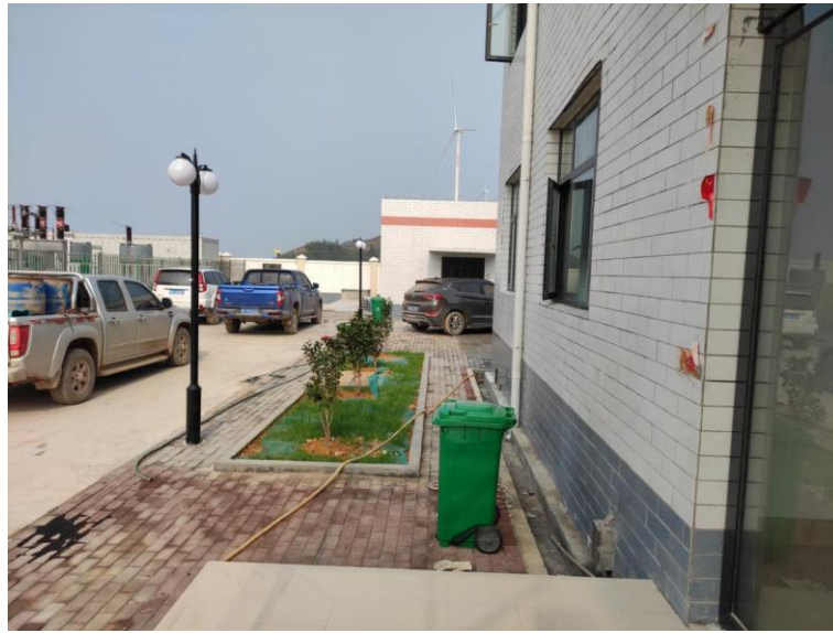
升压站生活垃圾收集点
