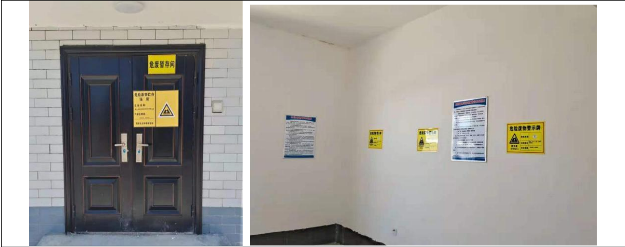
升压站危废暂存间
