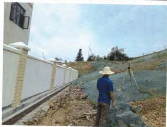
升压站北侧厂界外 5m 监测
