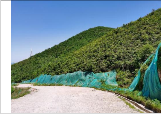
16#风机往升压站道路排水沟及边坡
