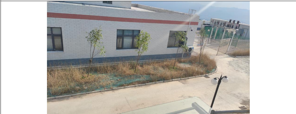
升压站内道路及场内绿化
