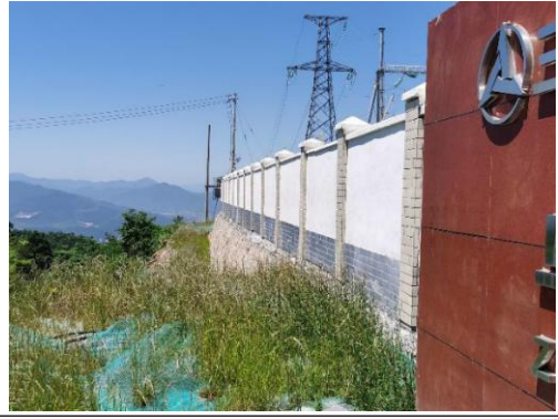
升压站东侧浆砌石挡墙
