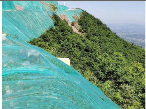
13~14#风机道路排水涵管
