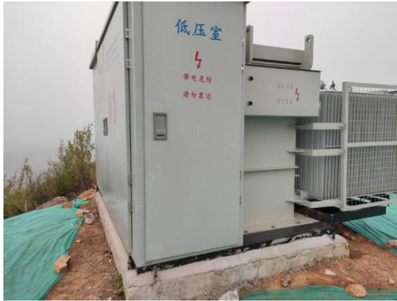
箱式变压器及基础
