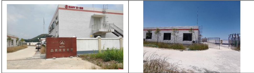
升压站门禁管理
