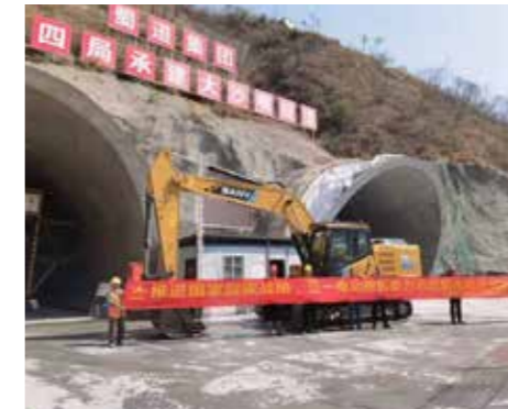
四川.隧道施工
