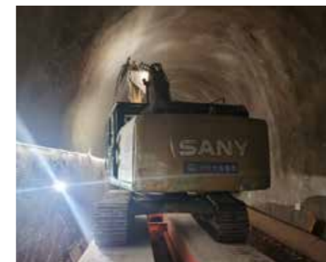
云南.隧道施工
