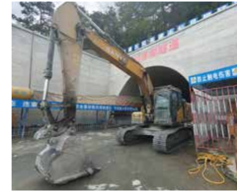
广西.隧道施工
