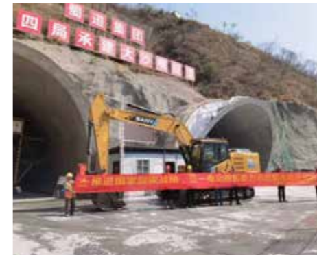
四川.隧道施工
