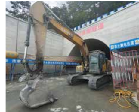
广西.隧道施工
