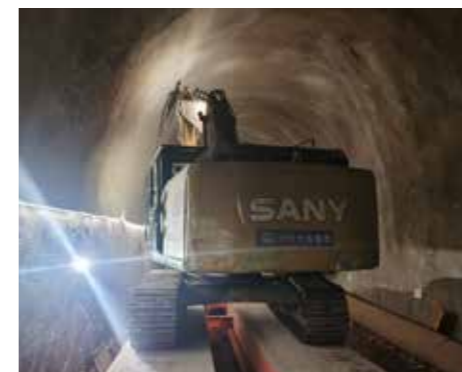
云南.隧道施工
